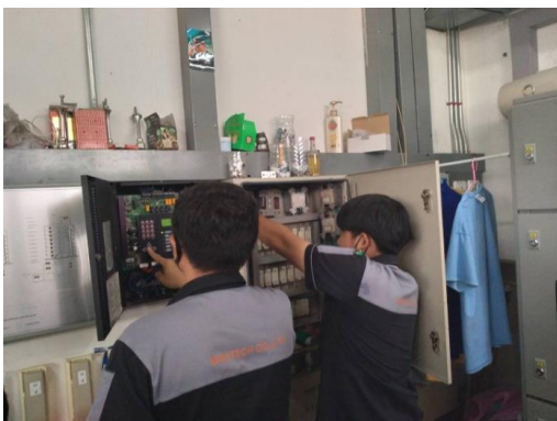
เจ้าหน้าที่ตรวจสอบ Fire Alarm Control Panal : FCP
