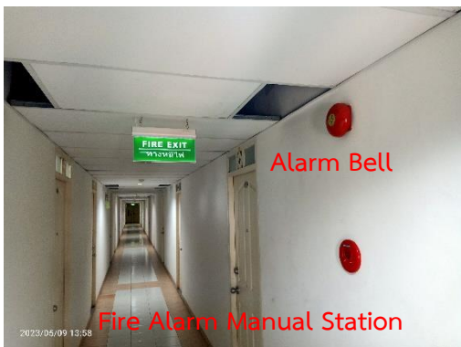
Fire Alarm Manual Station และ Alarm Bell
