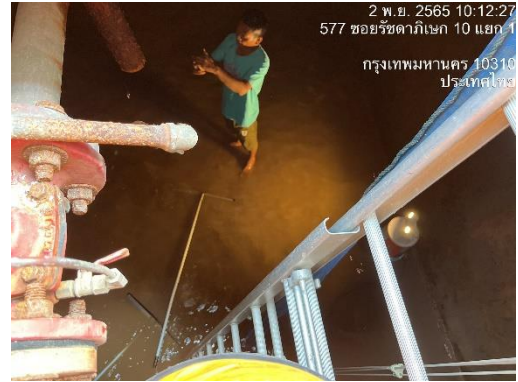
ภาพที่ 2-8 เจ้าหน้าที่ตรวจสอบระบบประปา และ ล้างถังเก็บน้ำ
