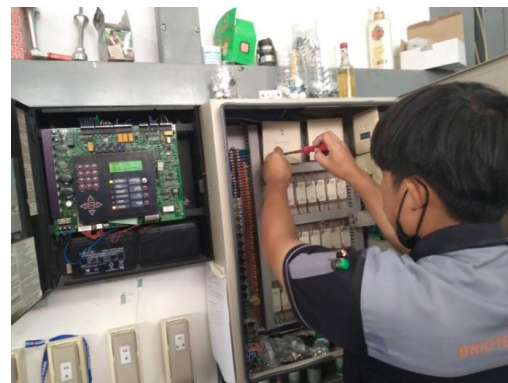
เจ้าหน้าที่ตรวจสอบ Fire Alarm Control Panal : FCP
